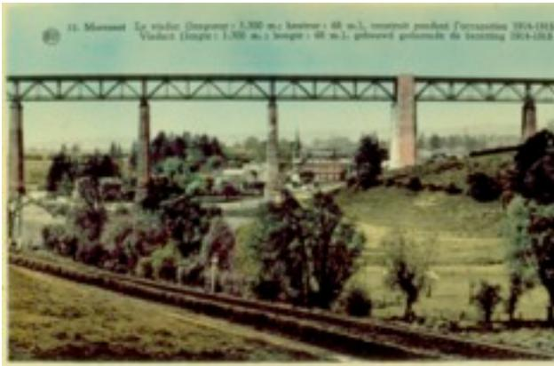
Das Viaduct von Moresnet, Länge 1300 m, Höhe bis zu 68 m, gebaut während der Besetzung 1914-18
