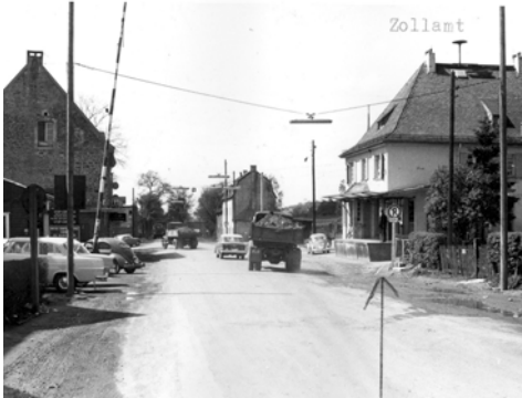
Wiedererrichtetes Zollamt an der Lütticher Straße mit Baracken 1958
