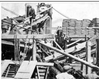
Westwallarbeiter am Werk
