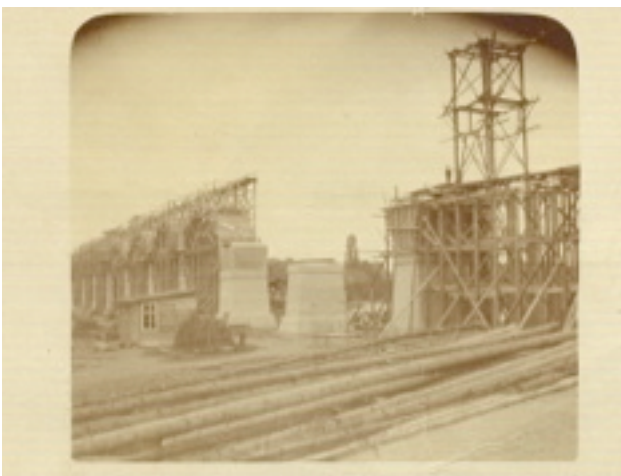
Brückenansicht während des Bau's
